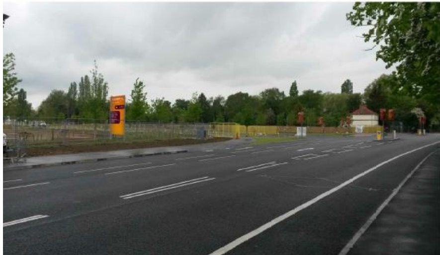
IM VISUAL ST2 - HUNTINGDON ROAD NORTH WEST
